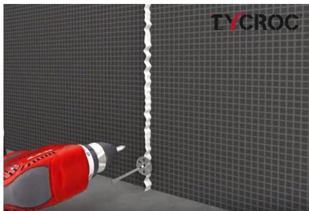
Для крепления строительной плиты Тусгос TWP на каркасе следует использовать шурупы для гипсокартона (подходящий тип шурупа зависит от каркаса) и крепежные шайбы Тусгос 36 × 0,6 мм. Используемые шурупы должны проникать в основание / каркас как минимум на 20 мм. Шурупы следует закреплять на каркасе с шагом 500 мм. При последующей отделке (шпаклевка / покраска) строительные плиты можно крепить к каркасу kleem-герметиком Тусгос Premium FIX и шурупами, не используя крепежные шайбы.
