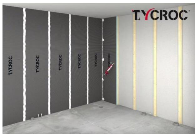
Для изоляции торцов труб использовать kleem-герметик Тусгос Premium FIX или, если проходы слишком велики, подходящую изоляционную манжету и гидроизоляционную мастику.
