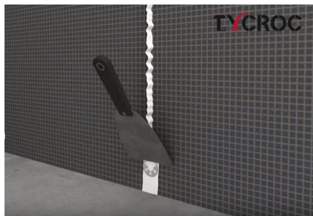
Используя шпатель, изолировать клем-герметиком промежутки между строительными плитами, углы и другие проходы, покрыв им также металлические дюбели. В душевом углу и других углах стена / стена или стена / пол, входящих в непосредственный контакт с водой, дополнительно использовать изоляционную ленту и гидроизоляционную мастику. Для изоляции торцов труб использовать клем-герметик Tycroc Premium FIX или, если проходы слишком велики, подходящую изоляционную манжету и гидроизоляционную мастику.
