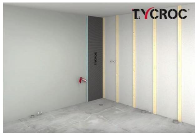
Чтобы склеить строительные плиты между собой или изолировать их, перед установкой следующей плиты нанести на край предыдущей плиты клей-герметик Тусгос Premium FIX.
