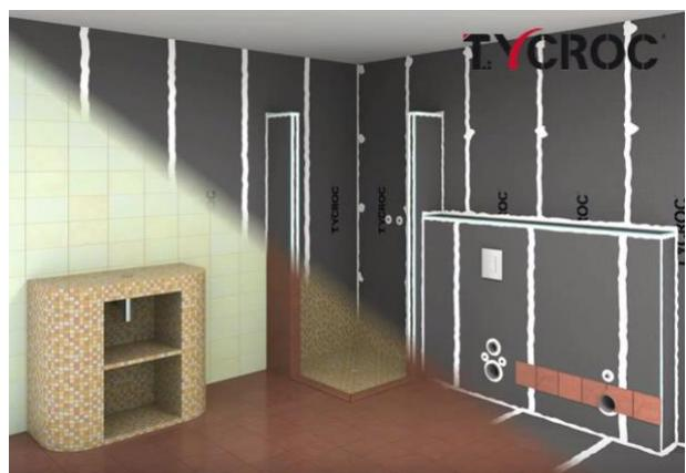
Virsma uzreiz ir gatava flīžēšanai vai cita veida apdarei. Uzmanību! Ja Tycroc TWP celtniecības plāksnes tiek izmantotas tikai sienu izbūvēšanai, grīdas hidroizolācija jāveic saskaņā ar hidroizolācijas ražotāja uzstādīšanas pamācību.
